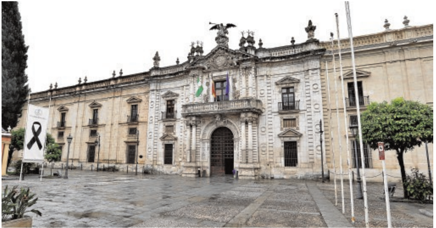
Fachada de la antigua Fábrica de Tabacos, hoy acceso al Rectorado de la Universidad de Sevilla
