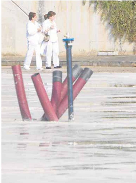
Obras previas en el hospital de campaña junto a La Fe. J. SIGNES
